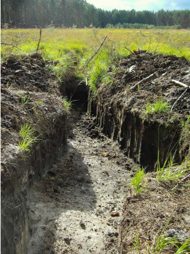
Binnenentwässerungsgraben am Moorrandbereich mit Verplombungsvorbereitungen (R. Meier)
